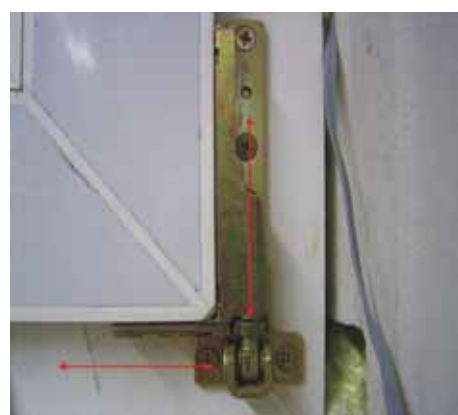
Bild 6 Verstellbares Scharnier
