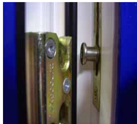
Bild 5 Runder Zapfen im mit Einschlussblech
